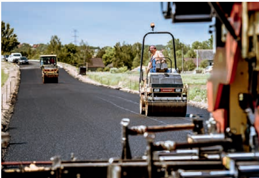
Zagęszczanie dwuwarstwowej cichej nawierzchni z asfaltu porowatego na Obwodnicy Gdowa, fot. LOTOS Asfalt
