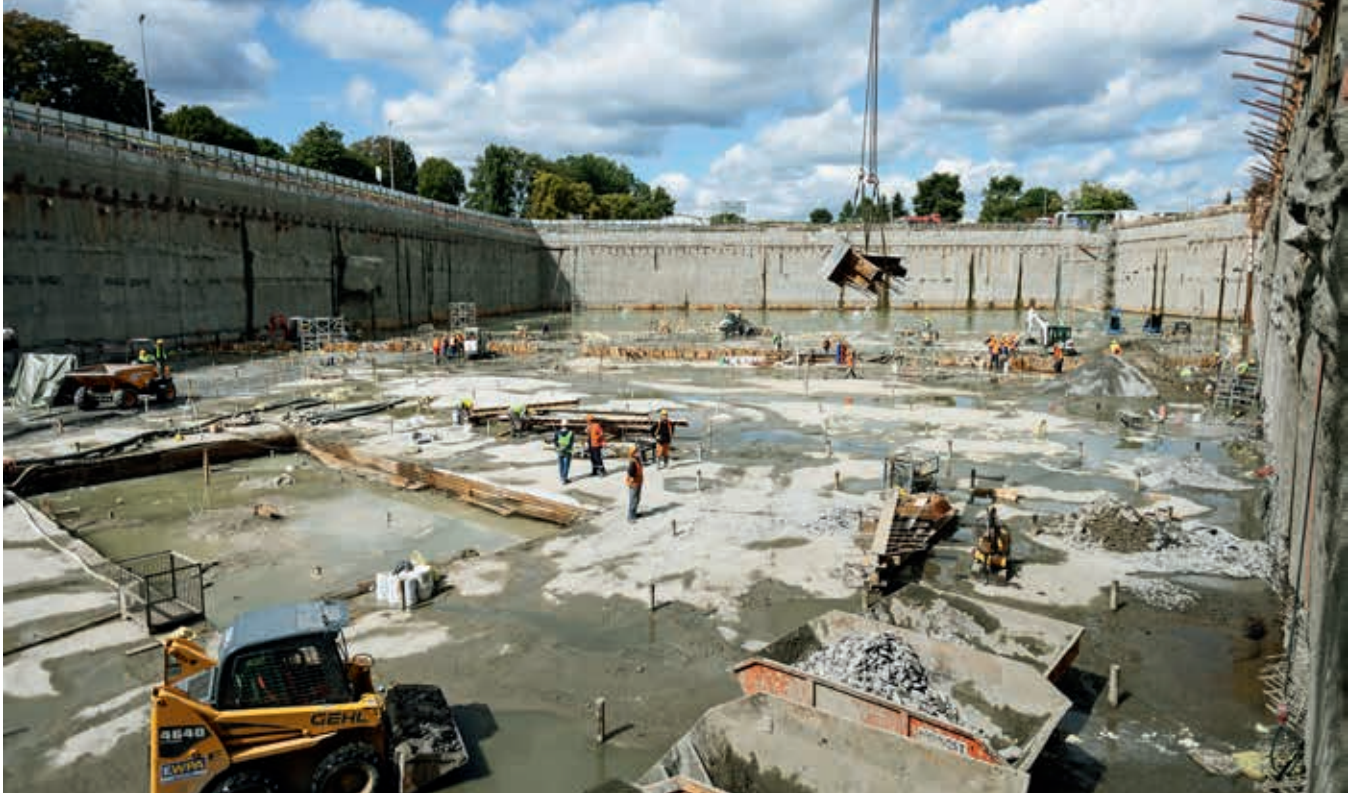
Czyszczenie, doszczelnianie i wyrównywanie dna wykopu, sierpień 2014 r., fot. R. Jocher
