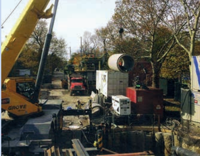
Ryc. 1. Projekt DWIRS – widok na plac budowy, na pierwszym planie szyb startowy MTBM [1]
