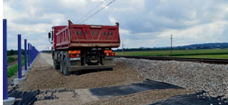
Zastosowanie geosyntetyków do wzmocnienia podtorza, fot. Elikopol BK Sp. z o.o
