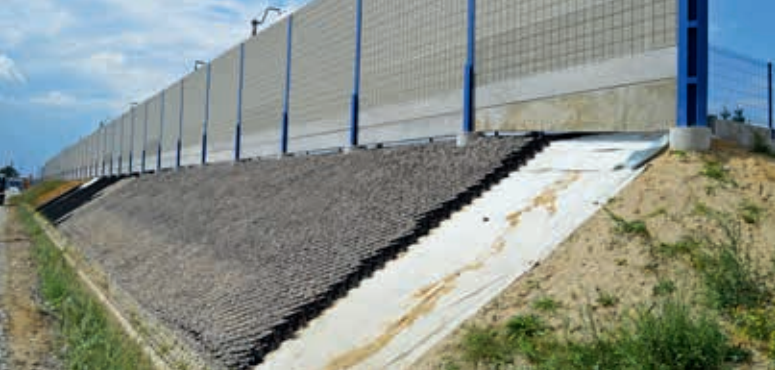
Zastosowanie geosyntetyków do umocnienia skarp (geokrata ElikopolBasic), fot. Elikopol BK Sp. z o.o
