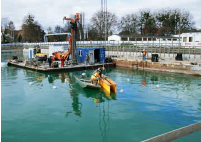
Przygotowania do próbnych obciążeń
