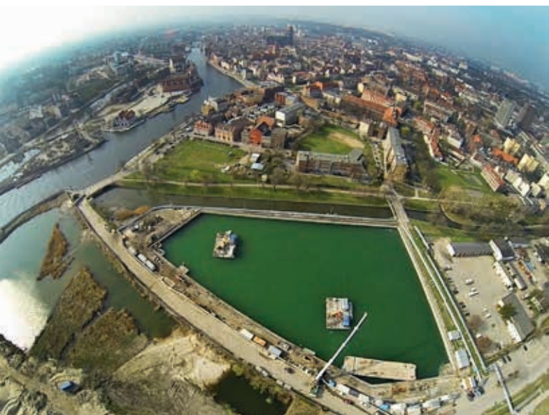
Widok na teren budowy z lotu ptaka
