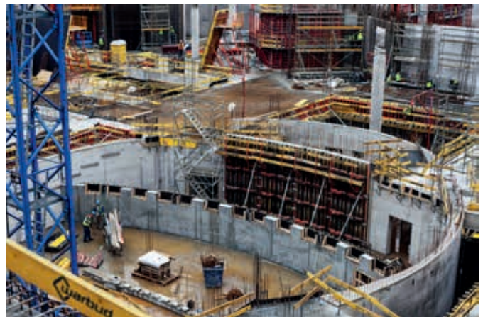
Budowa sali konferencyjnej Muzeum, fot. R. Jocher
