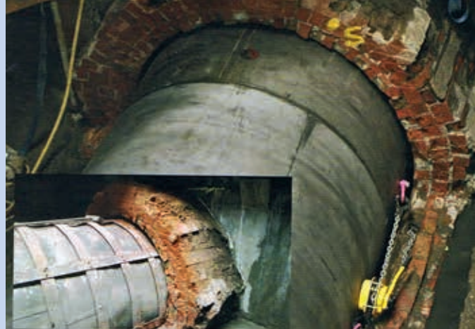
Ryc. 8. Wprowadzanie stalowej rury Duplex do istniejącego kanału murowanego [2]
