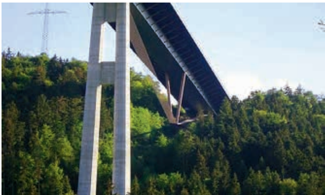
Ryc. 3. Wiadukt Weitingen, fot. K. Gotsch, structurae.net
