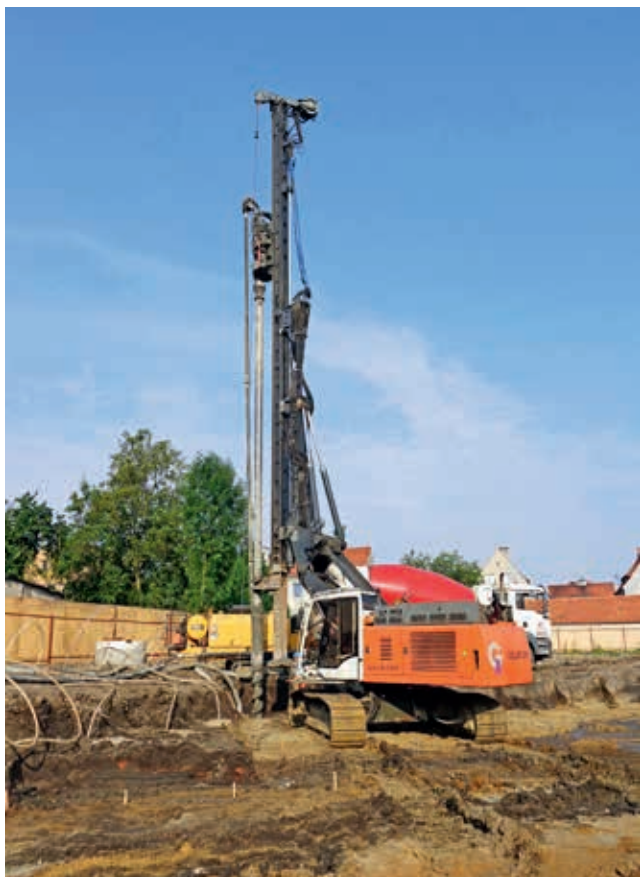
Ryc. 2. Palownica w trakcie wykonywania kolumn CMC
