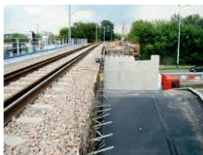
Ryc. 7 i 8. Wykonanie drugiego etapu montażu – konstrukcja TechSpan® pod torem nr 2
