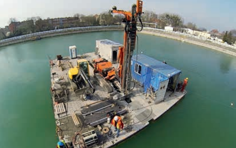
Wykonywanie mikropali z platform pływających
