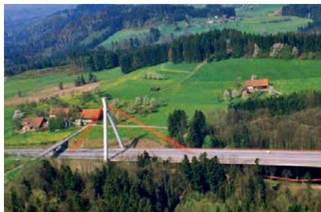
Ryc. 8. Wiadukt Obere Argen, fot. Schlaich, Bergermann und Partner, structurae.net
