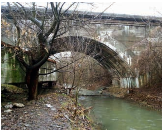
Ryc. 2. Wiadukt kolejowy w Krakowie przed przebudową
