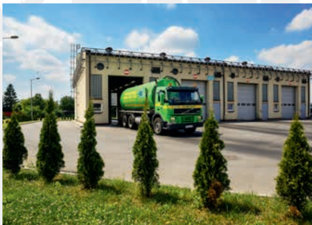
Nowa stacja zlewna na Oczyszczalni Ścieków Płaszów
