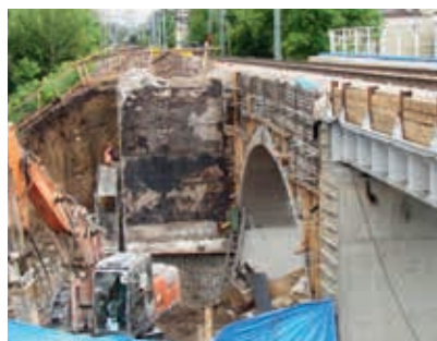
Ryc. 5 i 6. Konstrukcja TechSpan® pod torem nr 1
