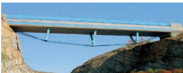
Ryc. 4. Wiadukt Truc de la Fare, fot. Mossot, fr.wikipedia.org
