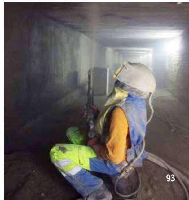
Nakładanie torkretu na powierzchnię stropową tunelu – wykonawca DEKOR-SERVICE, fot. Michał Przedwojewski, quick-mix
