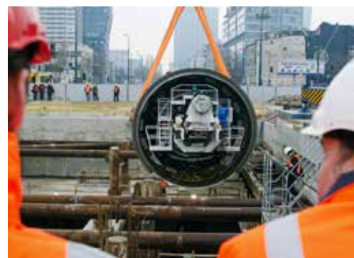
Opuszczanie do szybu pierwszego TBM-u, fot. AGP
