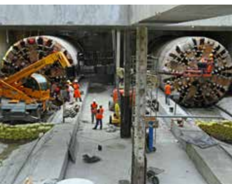
TBM-y w komorze rozjazdu, fot. M. Żuchowski, AGP
