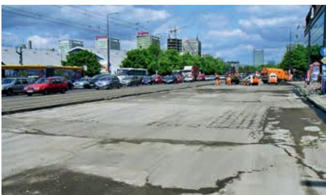
Droga w trakcie remontu, fot. Instytut Badawczy Dróg i Mostów
