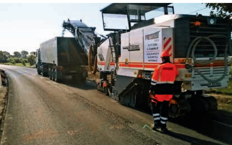
Odnowa nawierzchni, Barcin fot. Zarząd Dróg Wojewódzkich w Bydgoszczy
