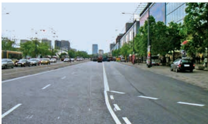
Droga po remoncie, fot. Instytut Badawczy Dróg i Mostów
