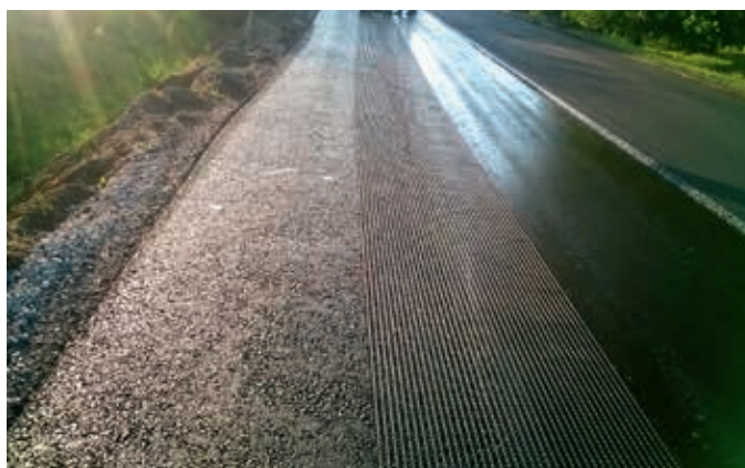
Remont drogi, fot. Zarząd Dróg Wojewódzkich w Bydgoszczy
