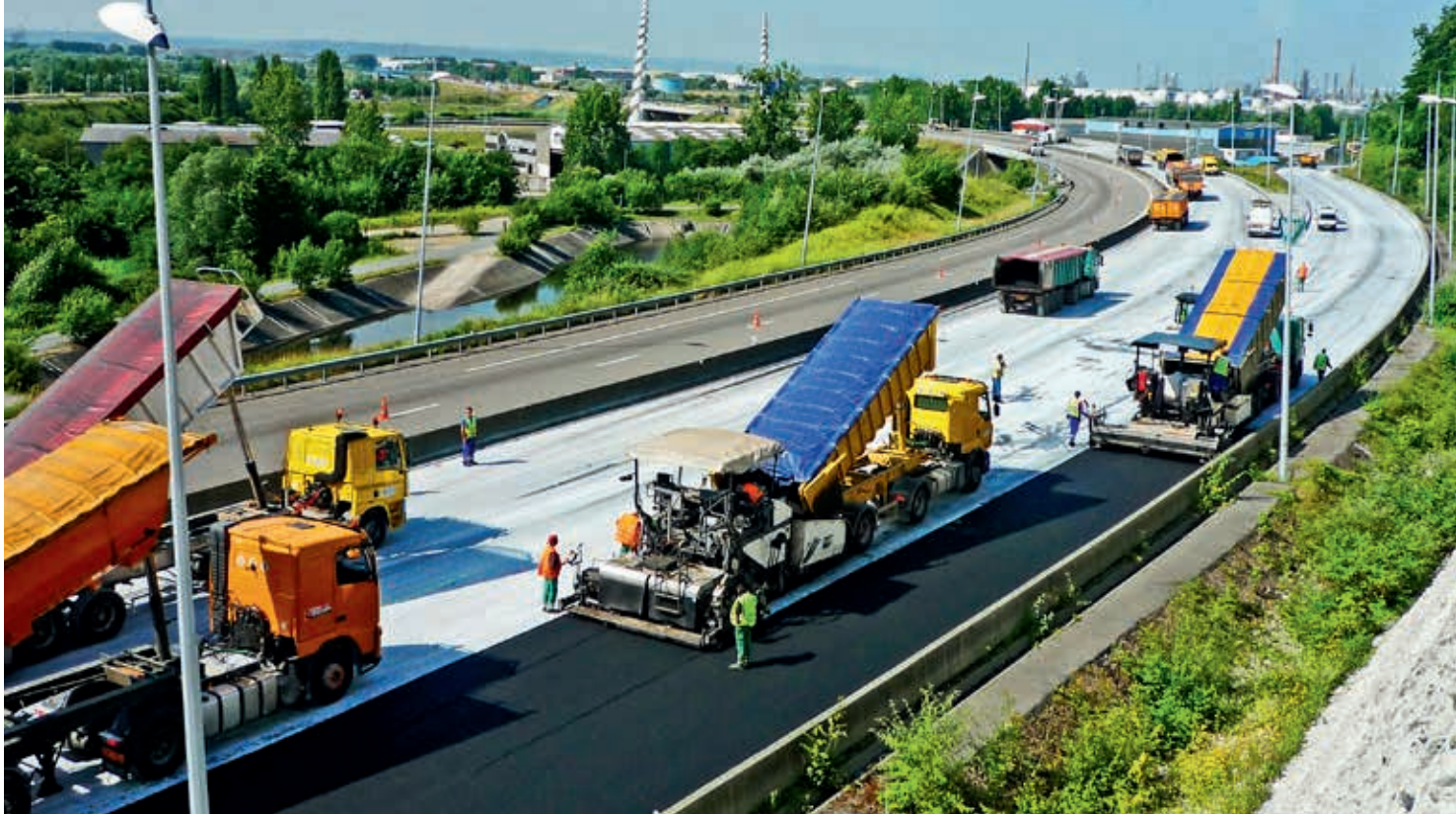
Zabezpieczenie warstwy szcpej podczas remontu jednej z francuskich autostrad, fot. Lhoist
