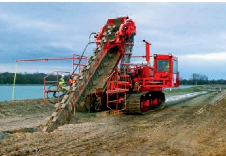
Trencher Mastenbroek, fot. Soletanche Polska Sp. z o.o.
