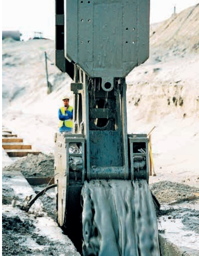
Przegrody przeciwnofiltracyjne wykonywane w technologii jednofazowych ścianek szczelnych, fot. Górażdże Cement SA
