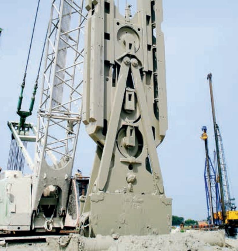
Przegrody przeciwfiltracyjne wykonywane w technologii jednofazowych ścianek szczelnych, fot. Górażdże Cement SA
