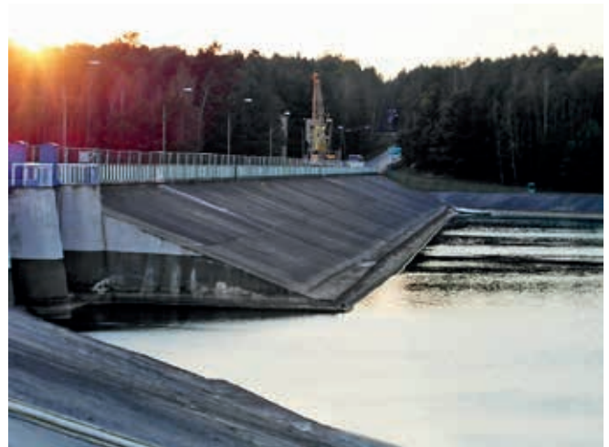
Ryc. 5. Głębiarka na koronie zapory Chańcza
