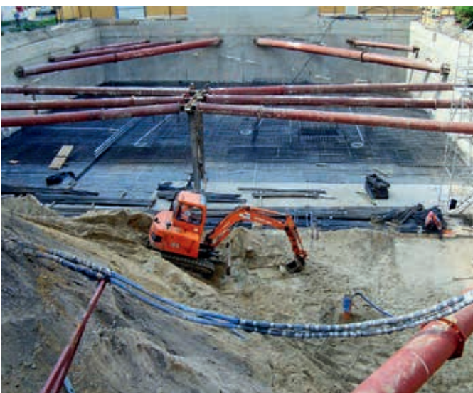
Ryc. 8. Warszawa, Stodowiec Park, suchy wykop
