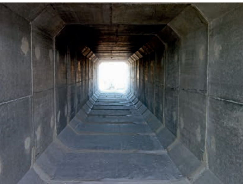
Typowy obecnie stosowany prefabrykowany przepust żelbetowy pod drogą ekspresową w centralnej Polsce, fot. A. Wysokowski
