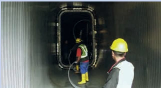
Ryc. 3. Odnowa kanału prostokątnego z wykorzystaniem technologii SPR Spiral-Wound [5]
