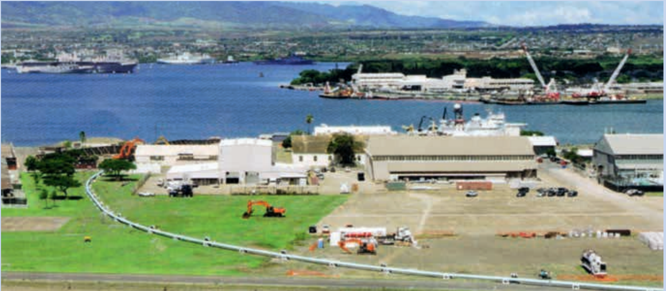
Ryc. 2. Rurociąg ze zgrzewanego PVC przed zainstalowaniem [5]
