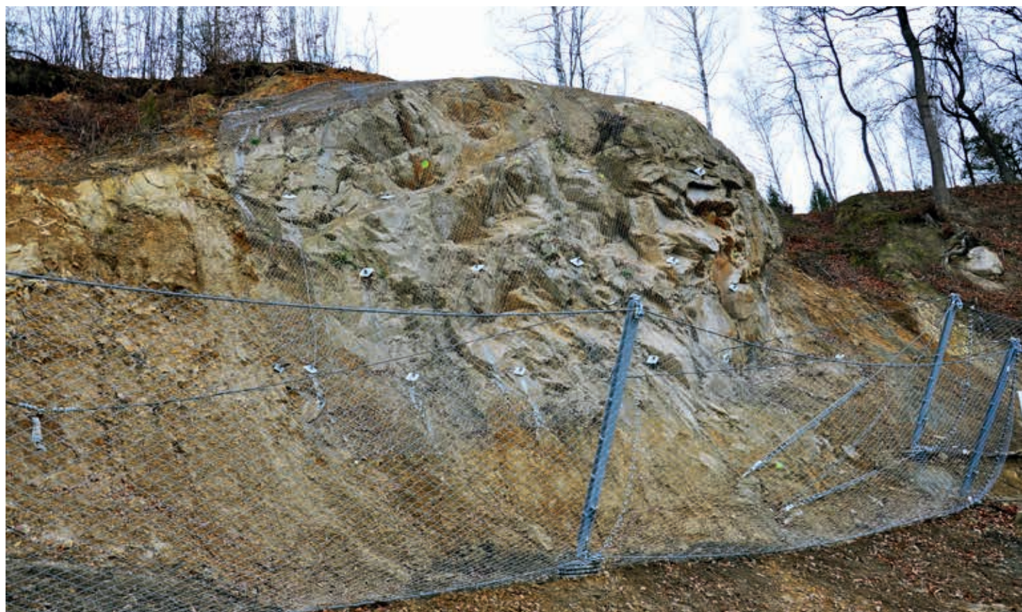
Bariera przeciwdławkowa w Kamyku, fot. Zakład Inżynieryjny Georem Sp. z o.o.
