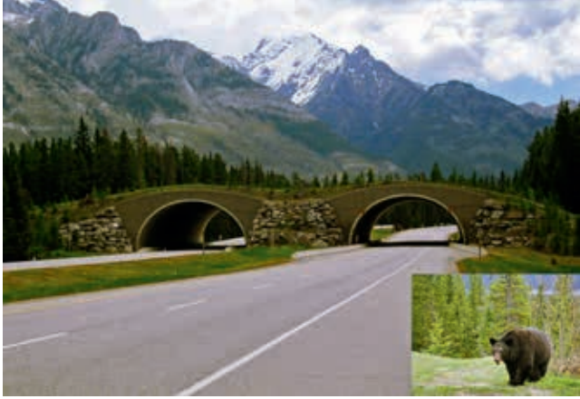
Rys. 3. Przykład przejścia dla zwierząt nad autostradą w okolicy Calgary (Kanada) dla dziko żyjących niedźwiedzi, fot. Z. Juskiewicz
