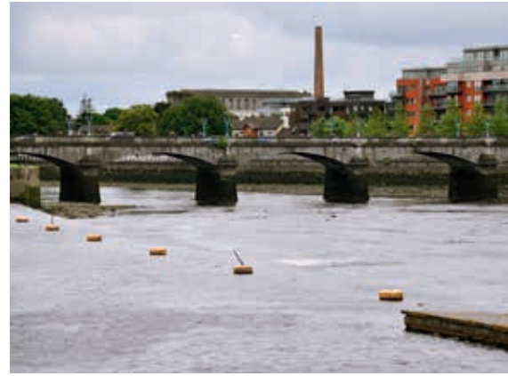
Ryc. 11. Pięcioprzęsłowy, żelbetonowy most belkowy Matthew Bridge przez rzekę Shannon w Limerick (obiekt nr 25)
