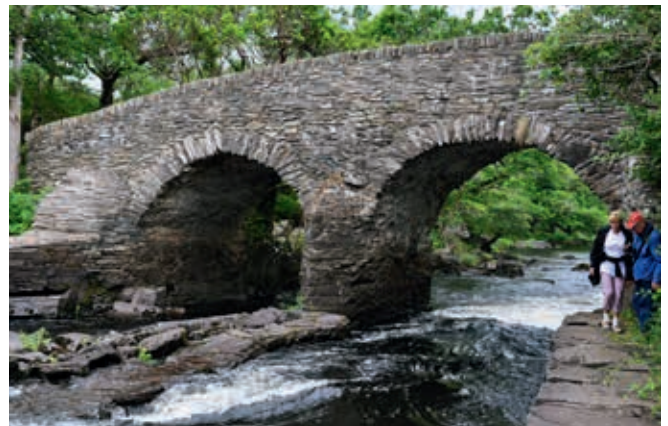
Ryc. 28. Stary most jazowy – Old Weir Bridge (obiekt nr 32)
