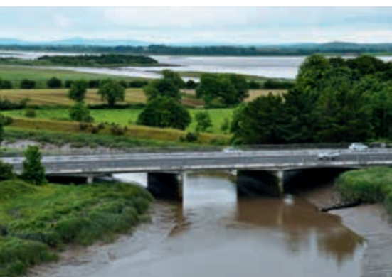
Ryc. 9. Czteroprzęsłowy most żelbetowy przez rzekę Shannon (obiekt nr 23)
