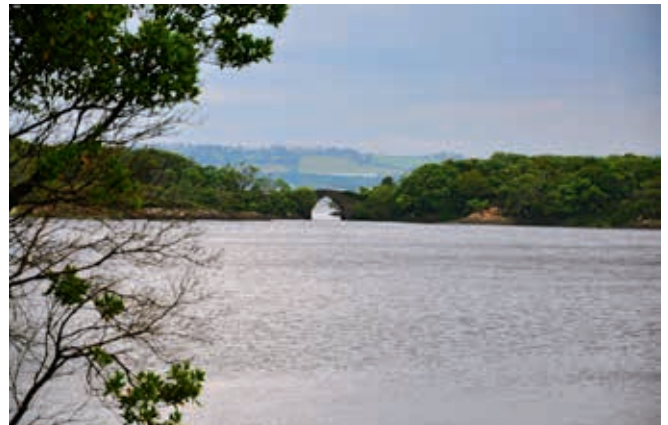
Ryc. 27. Brickeen Bridge między jeziorami Muckross Lake i Lough Lane (obiekt nr 31)
