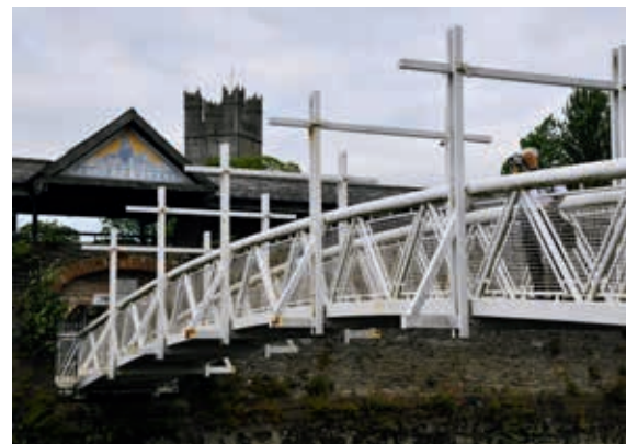
Ryc. 12. Stalowa kładka dla pieszych przez rzekę Shannon w Limerick (obiekt nr 26)
