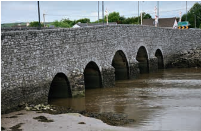
Ryc. 15. Kamienny most w Blerneville (obiekt nr 28)
