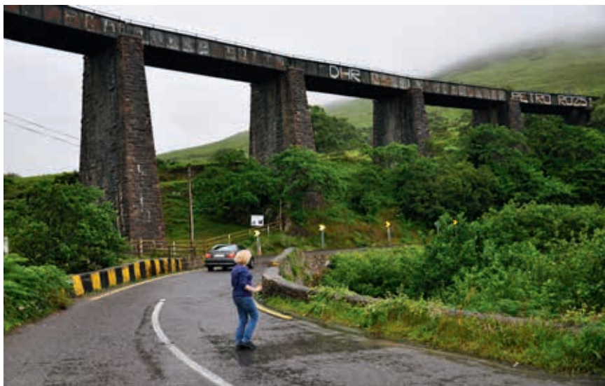
Ryc. 31. Wiadukt kolejowy Glensk (obiekt nr 33)
