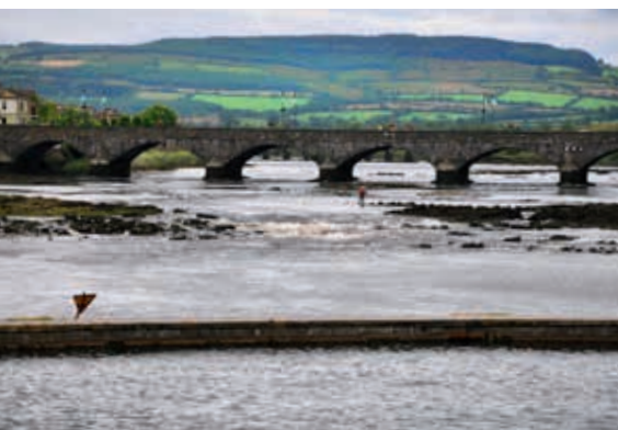
Ryc. 10. Średniowieczny, ośmioprzęsłowy, łukowy most kamienny Thomond Bridge przez rzekę Shannon w Limerick (obiekt nr 24)
