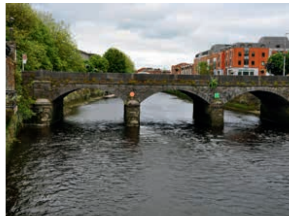
Ryc. 13. Trójprzęsłowy, kamienny most łukowy Sarsfield Bridge przez Shannon w Limerick (obiekt nr 27)
