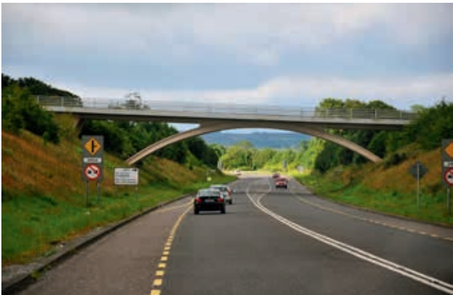
Ryc. 23. Betonowy most łukowy na drodze do Tralee
