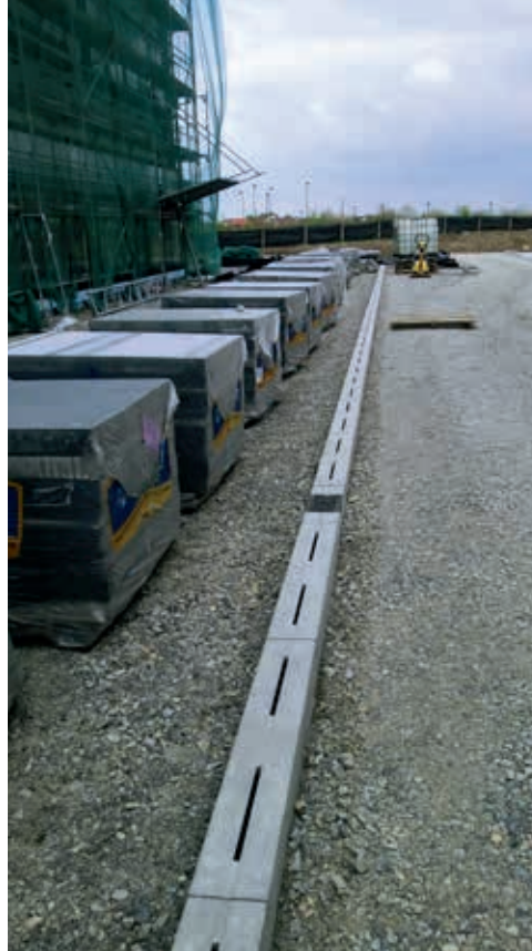
Odwodnienie liniowe City Drain 100 z przerywaną szczelinią
