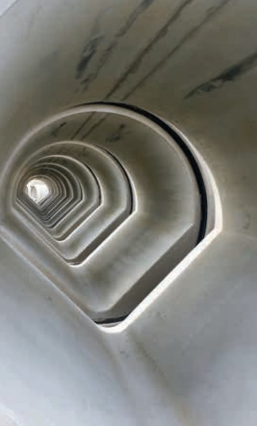
Rura żelbetowa DN 2000 z kinetą V-kształtną
