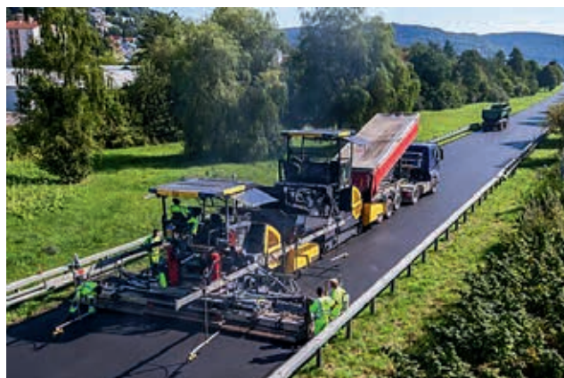
Zespół maszyn układający ścieralną warstwę nawierzchni asfaltowej z wykorzystaniem rozkładarki Dynapac SD2500CS oraz podajnika samobieżnego Dynapac MF2500CS, fot. Atlas Copco Polska Sp. z o.o.
