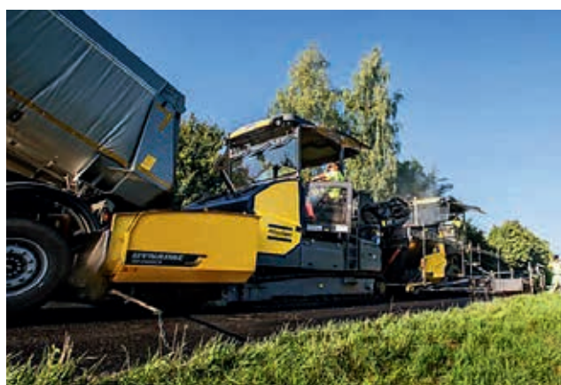
Ładunek mieszanki mineralno-bitumicznej do rozkładarki za pomocą podajnika samobieżnego Dynapac MF2500CS, fot. Atlas Copco Polska Sp. z o.o.
