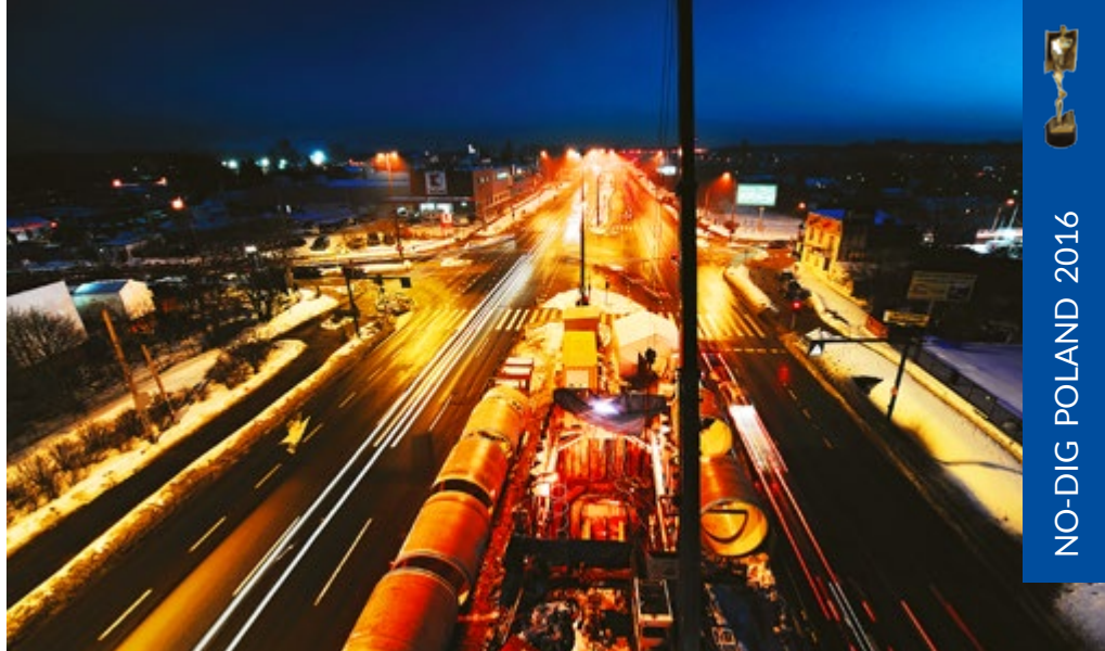
Budowa układu przesyłowego do oczyszczalni ścieków „Czajka” w Warszawie, fot. HOBAS System Polska Sp. z o.o.
