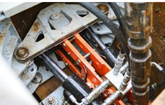
Maszyna ST-40 na placu budowy. Wymiana starego rurociągu jest wykonywana bez obecności pracownika w studni
