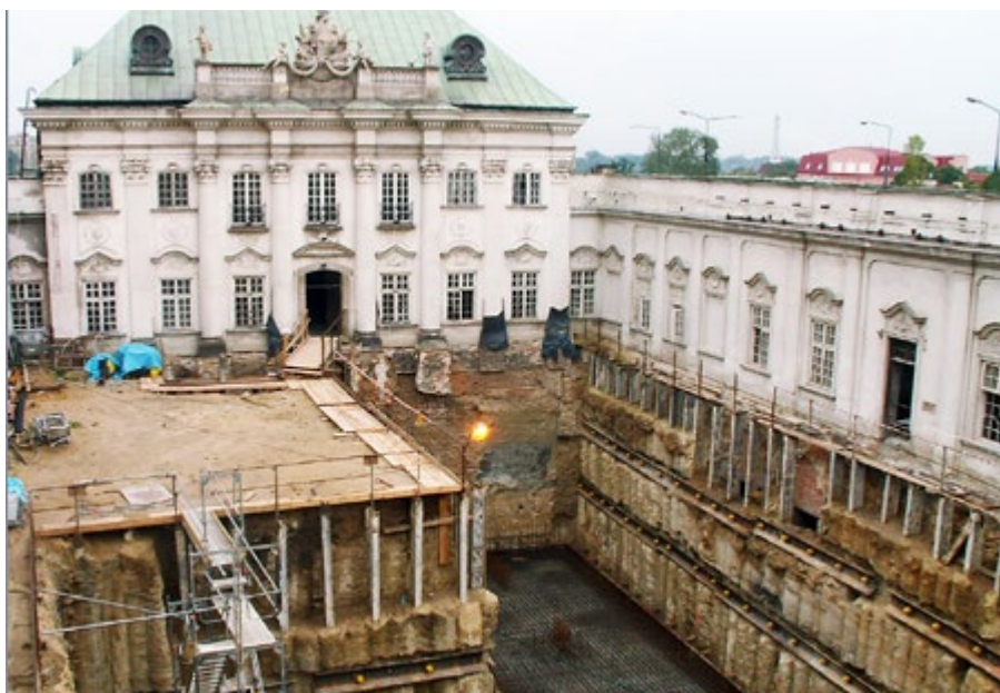
Pałac pod Błachą w Warszawie – palisada DSM, fot. Keller Polska Sp. z o.o.
