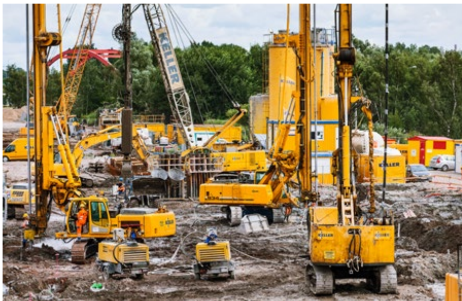
Tunel w Gdańsku – ściany szczelinowe i jet grouting, fot. Keller Polska Sp. z o.o.
