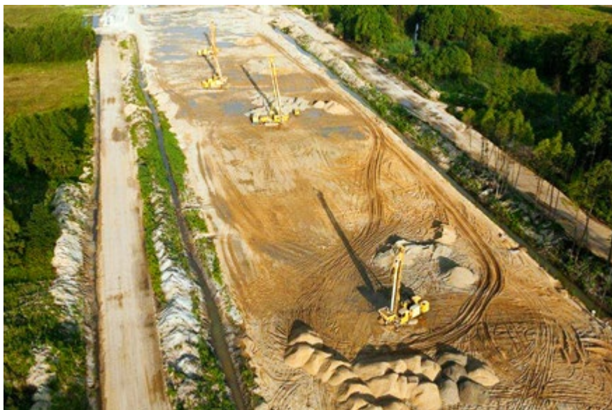
Autostrada A2 – kolumny żwirowe, fot. Keller Polska Sp. z o.o.
