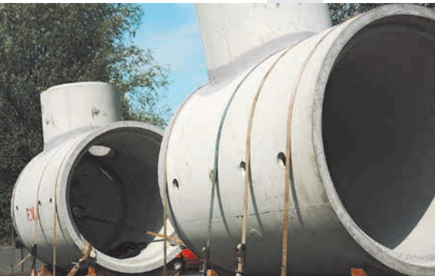
Przykład z realizacji: studzienka zintegrowana z kolektorem DN 1800, Tarnów w Małopolsce. Studzienka zintegrowana, przygotowana do transportu
