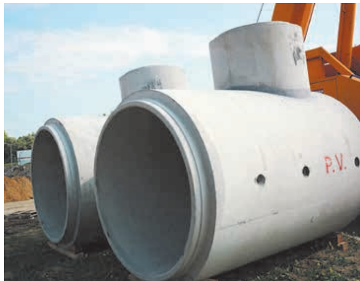
Studzienka zintegrowana, plac budowy przed montażem
