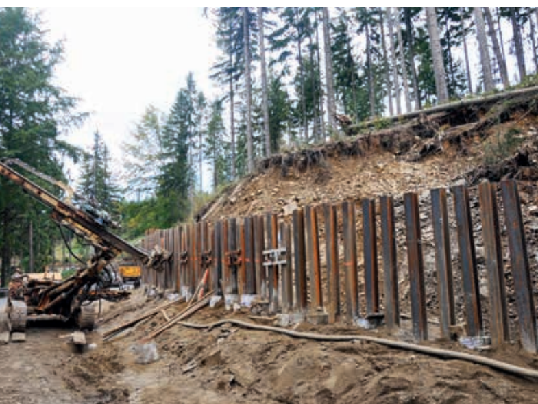
Zabezpieczanie osuwiska, kotwienie palisady, fot. Titan Polska Sp. z o.o.
