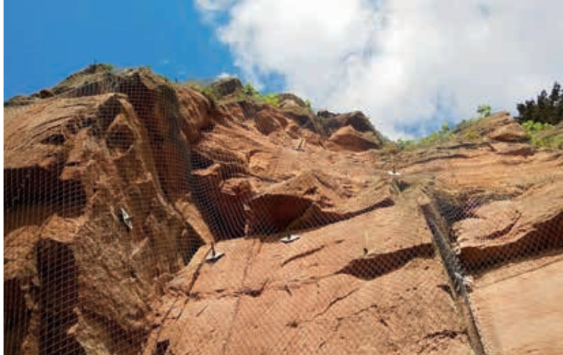
Geopark w Kielcach – TECCO SYSTEM3 (G65/3), fot. Geobrugg AG
