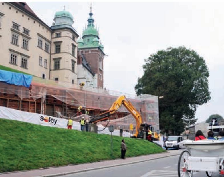
Prace geoinżynierskie, fot. Soley Sp. z o.o.
