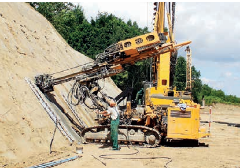
Kotwienie zbocza, Stump-Hydrobudowa Sp. z o.o.
