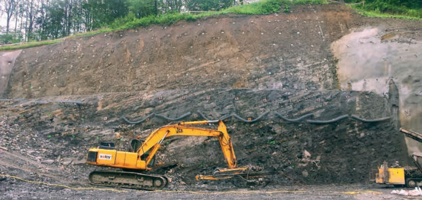
System gwoździ z oblicowaniem TECCO G65/3, Zakopane, fot. Geobrugg AG
