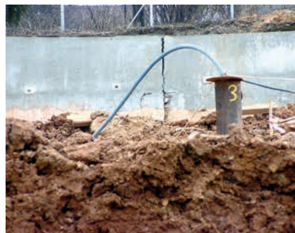
Studnia odwadniająca w rejonie głębokiego wykopu
