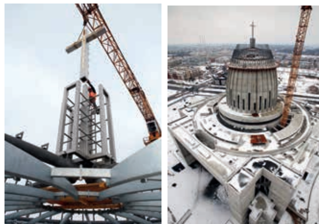
Ryc. 12. Montaż krzyża na konstrukcji stalowej świetlika, fot. Warbud SA
