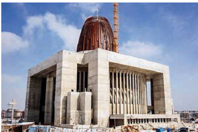
Ryc. 1. Widok świątyni z kopułą pokrytą blachą miedzianą (pierwotnie planowano obłożenie dachu blachą tytanowo-cynkową lub ze stali nierdzewnej, jednak o wyborze miedzi zdecydowała trwałość materiału; zużyto 30 t miedzi, 2012) [7]
