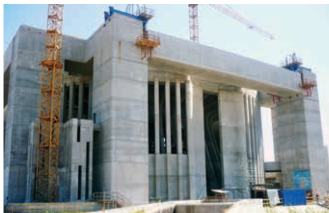
Ryc. 11. Faza podnoszenia – przed oparciem na pylonach
