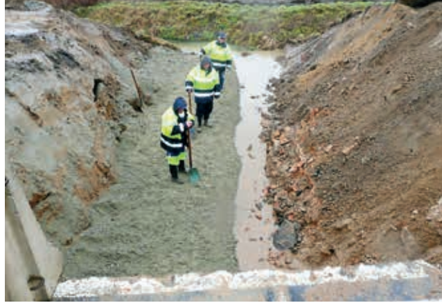
Ryc. 5. Widok przykładowego formowania fundamentu kruszywowego pod przepust skrzynkowy wykonywany metodą półówkową, fot. A. Wysokowski
