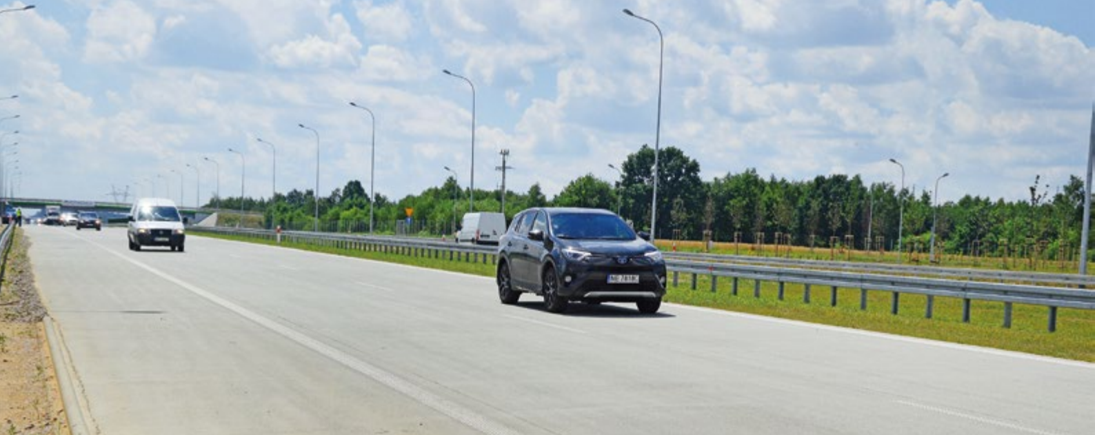
Ryc. 1. Betonowy odcinek autostrady A1 Stryków – Tuszyn
