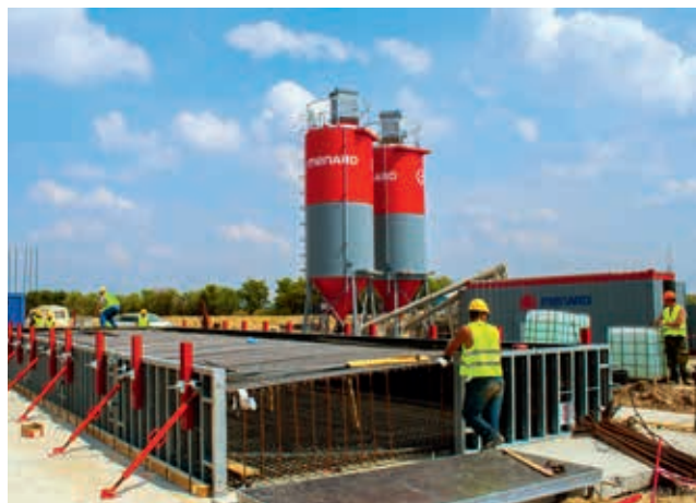
Ryc. 4. Etap szalowania fundamentów mostu
