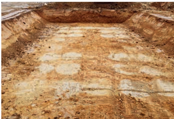
Ryc. 3. Powierzchnia pod filarem obiektu po wykonaniu kolumn DSM
