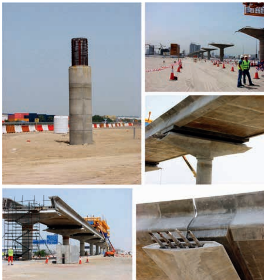
Ryc. 10. Metro w Dubaju – budowa estakad z segmentów prefabrykowanych, fot. J. Biliszczuk
