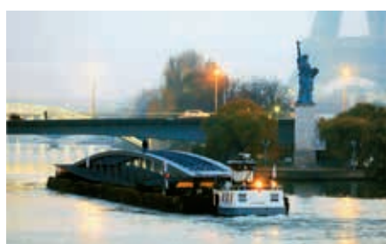
Ryc. 15. Kładka Simone de Beauvoir w Paryżu – transport głównego przęsła i widok gotowego obiektu [28]
