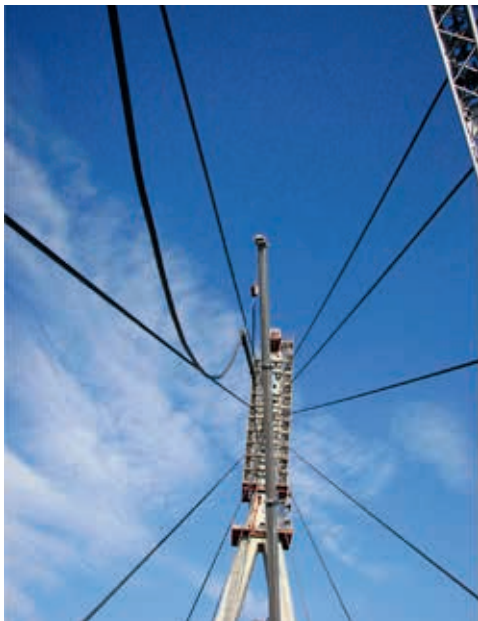
Ryc. 23. Prefabrykowane wanty zastosowane w podwieszonym moście przez Łabę w Dreźnie
