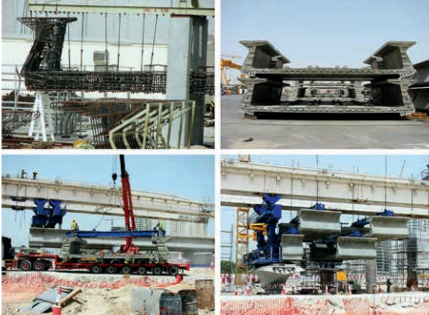
Ryc. 9. Metro w Dubaju – wytwarzanie, transport i montaż prefabrykowanych przęseł estakady, fot. J. Biliszczuk
