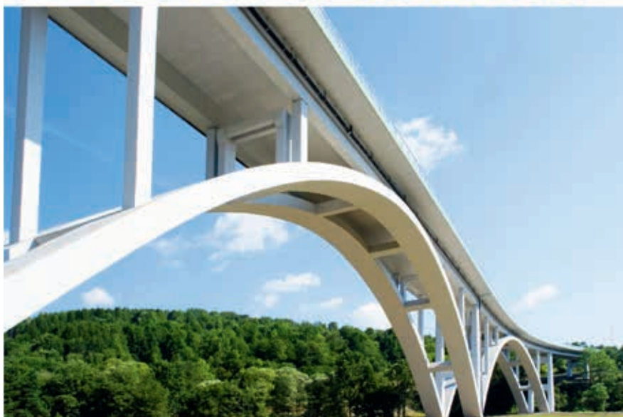
Ryc. 18. Zastosowanie wielkowymiarowych elementów prefabrykowanych łuków podczas budowy estakady przez dolinę Kameszniczanki w Milówce (2006) [31]
