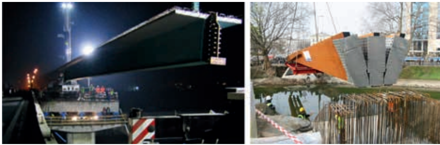
Ryc. 6. Obiekty zbudowane przy wykorzystaniu: a) stalowych belek prefabrykowanych typu VFT (most w ciągu autostrady A4), b) belek z drewna klejonego (Psia Kładka we Wrocławiu, 2009), fot. M. Suikowski
