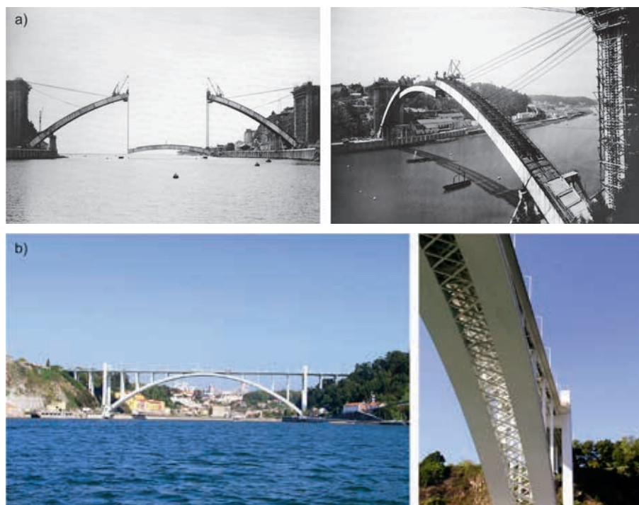
Ryc. 19. Most Arrabida w Porto: a) montaż elementu prefabrykowanego łuku o masie 2200 t (1963) [41]; b) widoki współczesne
