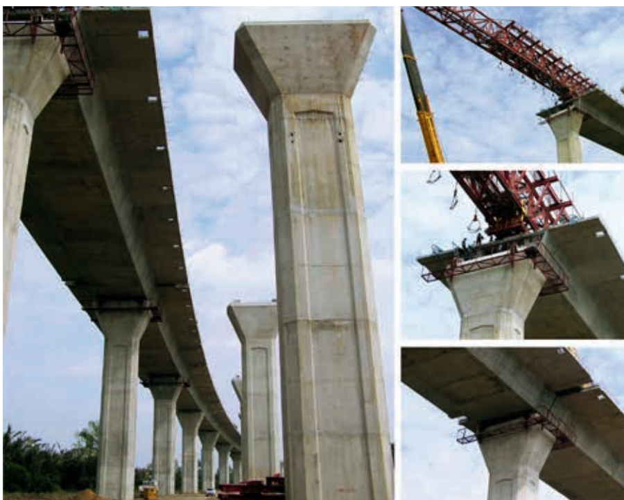
Ryc. 8. Estakada miejska wykonywana z segmentów prefabrykowanych w Bangkoku, fot. J. Biliszczuk
