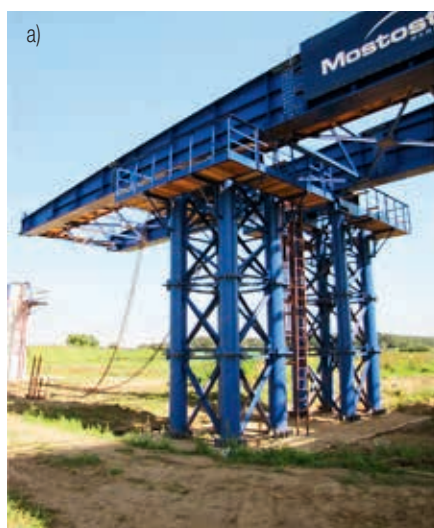
Ryc. 22. Prefabrykowane podpory tymczasowe: a) stalowe, stosowane na budowie mostu na Rędzinie, b) betonowe, stosowane przy budowie obiektu WA17. Oba obiekty są realizowane na autostradowej obwodnicy Wrocławia (AOW)
