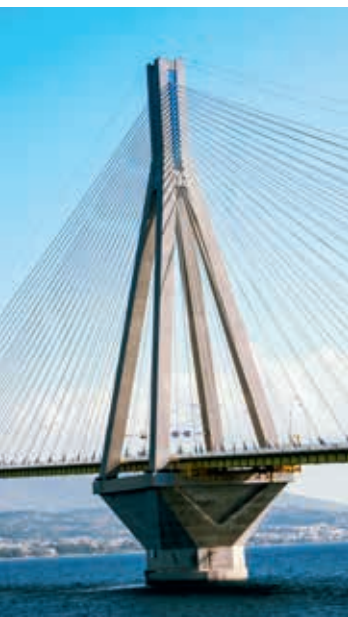
Ryc. 21. Prefabrykowana stopa fundamentu pylonu mostu podwieszono Rion-Antirion w Grecji (2004) i prefabrykowany keson mostu Zachodniego przeprawy przez Wielki Bełt w Danii (1995) [10], fot. mema, Sokarys
