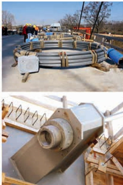
Ryc. 23. Prefabrykowane wanty zastosowane w podwieszonym moście przez Łabę w Dreźnie
