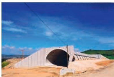
Ryc. 16. Prefabrykowane elementy do budowy małych łukowych przepustów i mostów [48]
