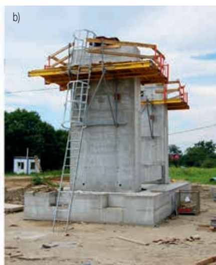
Ryc. 22. Prefabrykowane podpory tymczasowe: a) stalowe, stosowane na budowie mostu na Rędzinie, b) betonowe, stosowane przy budowie obiektu WA17. Oba obiekty są realizowane na autostradowej obwodnicy Wrocławia (AOW)
