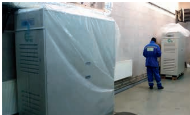
Turbiny biogazowe przygotowane do montażu w pomieszczeniu kogeneratorów
