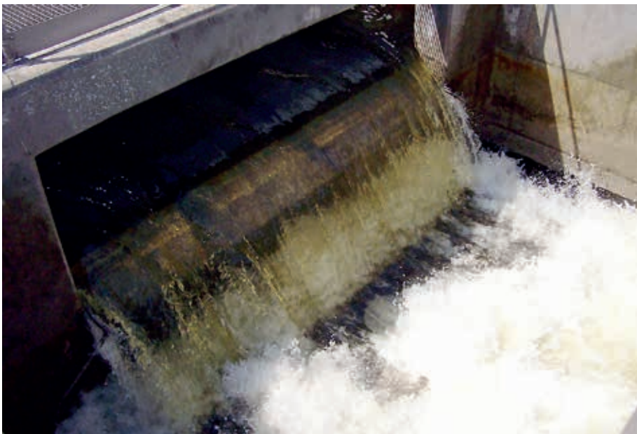
Istniejący układ zrzutu ścieków oczyszczonych do odbiornika
