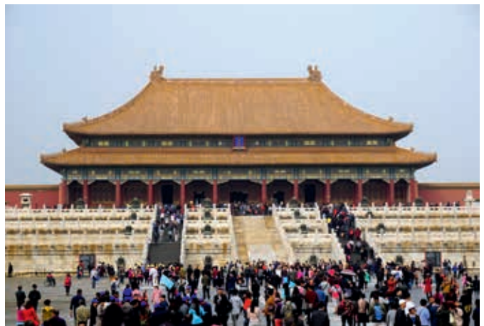
Ryc. 5. Filary budynków w Zakazanym Mieście wykonane z bardzo rzadkiego gatunku drewna cedrowego, sprowadzanego do Pekinu z oddalonej o 2 tys. km prowincji Syczuan, fot. J. Mazur
