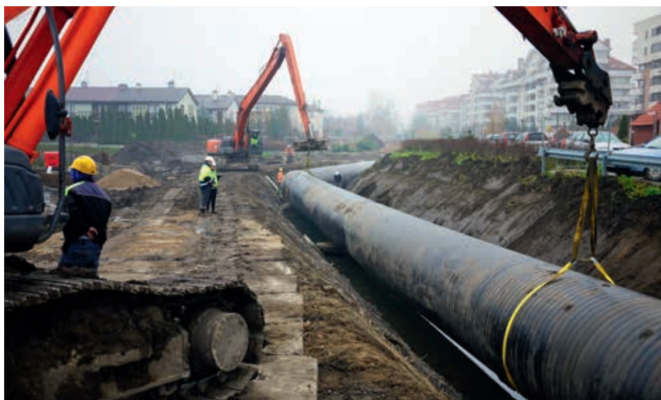
Układanie rurociągu w przygotowanym wykopie kanału
