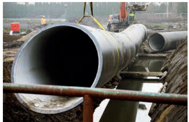
Montaż 50-metrowego odcinka z dospawanym łukiem
