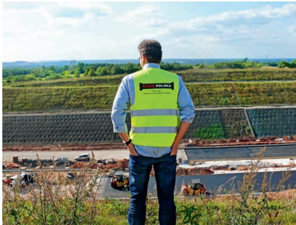
Budowa autostrady A1, Piekary Śląskie – Pyrzowice
