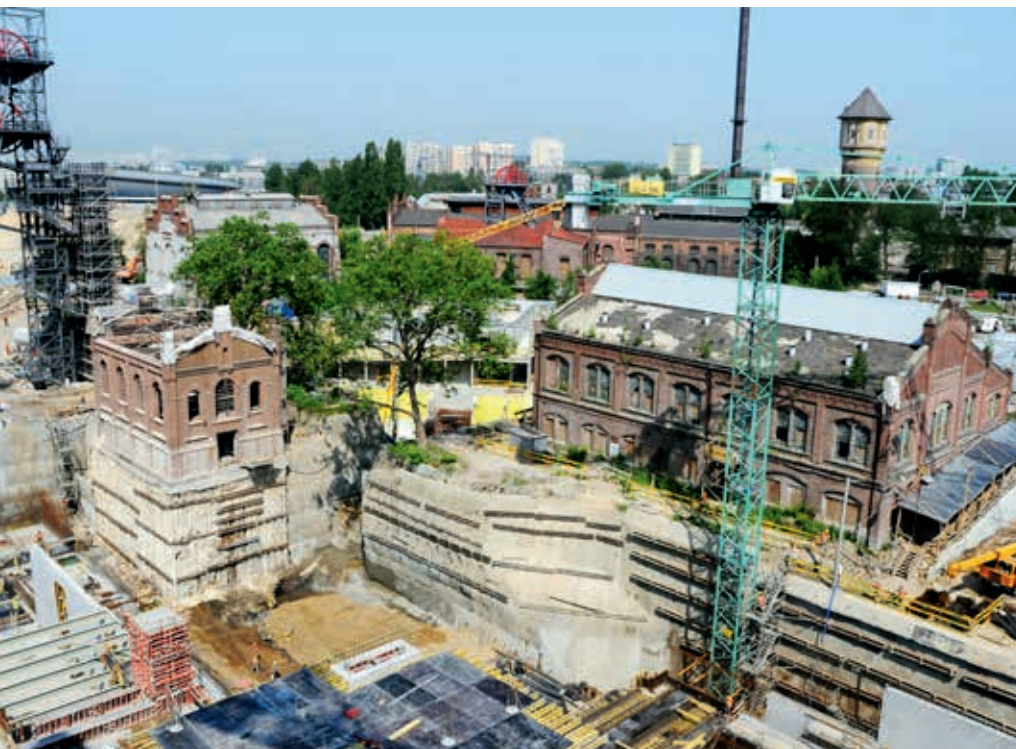
Budowa nowej siedziby Muzeum Śląskiego
