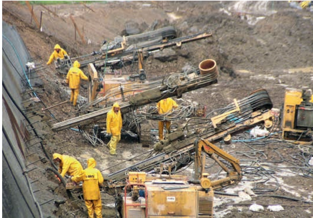
Budowa drogi ekspresowej S-69, Zwardoń
