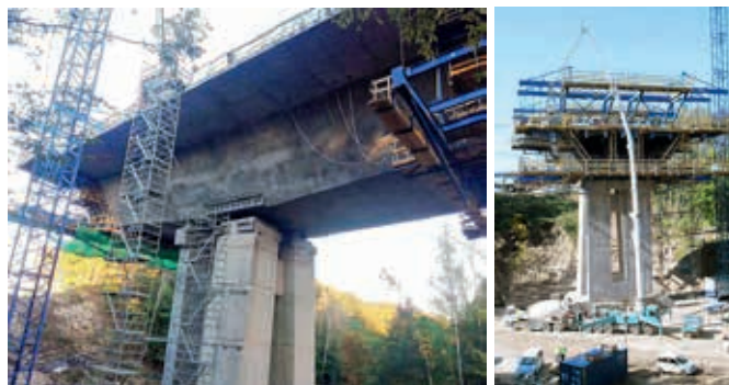
Ryc. 9. Widoki podpór obiektu MS-3 DK-16 w trakcie realizacji
