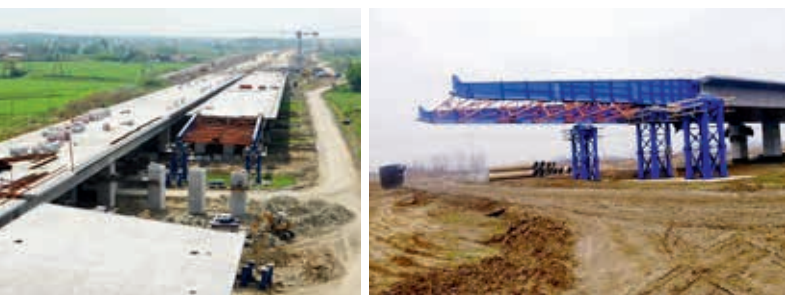
Ryc. 5. Zdjęcia z realizacji obiektu E-118 w technologii nasuwania podłużnego
