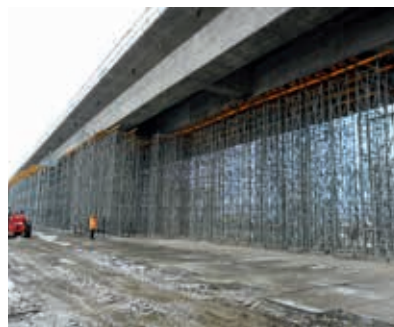
Ryc. 4. Widok rusztowania obiektu MS-31
