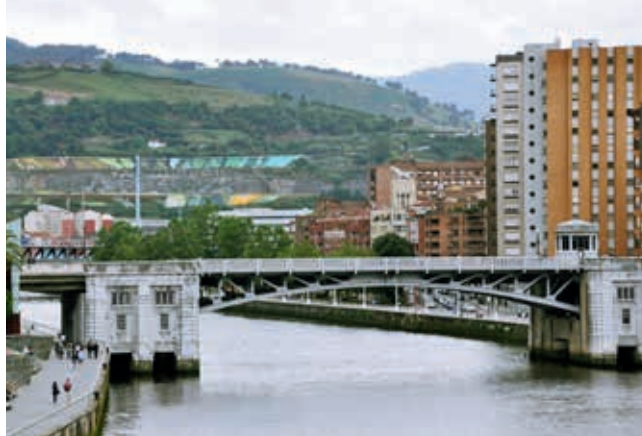
Most Duesto (obiekt nr 16)
