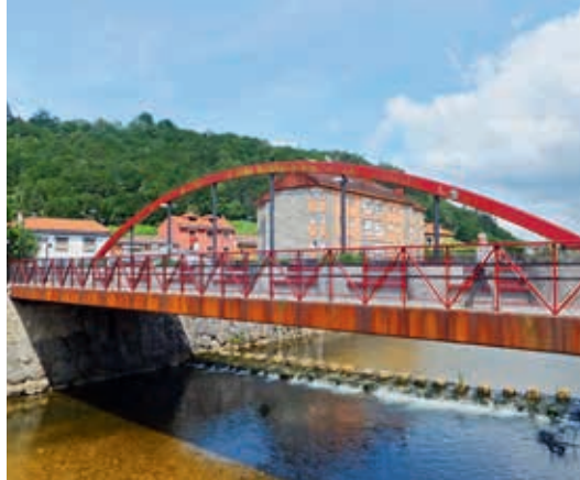
Łukowa kładka w Cangas de Onís (obiekt nr 25)
