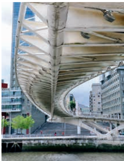
Most Zubizuri. Konstrukcja pomostu
