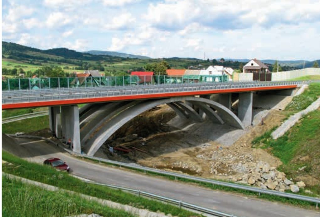
Wiadukt w ciągu obwodnicy miejscowości Lubień
