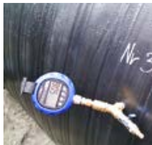
Badanie szczelności zbiornika Weholite
