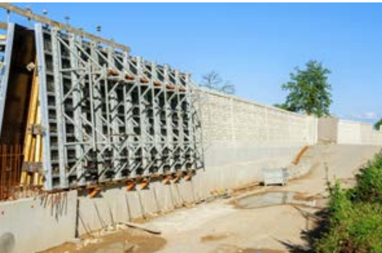
Trzpienie odciskowe w dolnym obszarze zapewniają delikatne rozszalowanie
