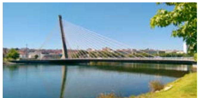
Stalowy most podwieszony Los Tirantes w Pontevedrze (obiekt nr 38)
