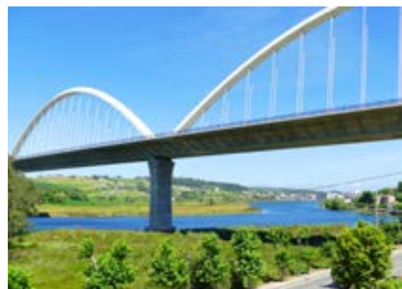
Viaducto del Navia, fot. K. Feigel-Młodkowska
