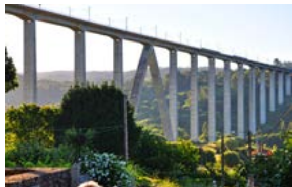
Wiadukt O Eixo w Galicji (obiekt nr 32), fot. K. Flaga
