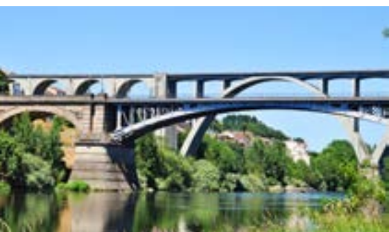
Obiekty mostowe nr 45 i 46 przez Minio Ourense, fot. K. Flaga
