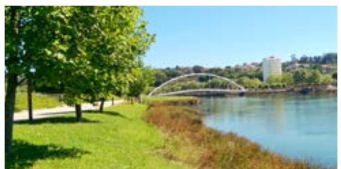
Stalowa, łukowa kładka dla pieszych przez Lerez w Pontevedrze (obiekt nr 39)
