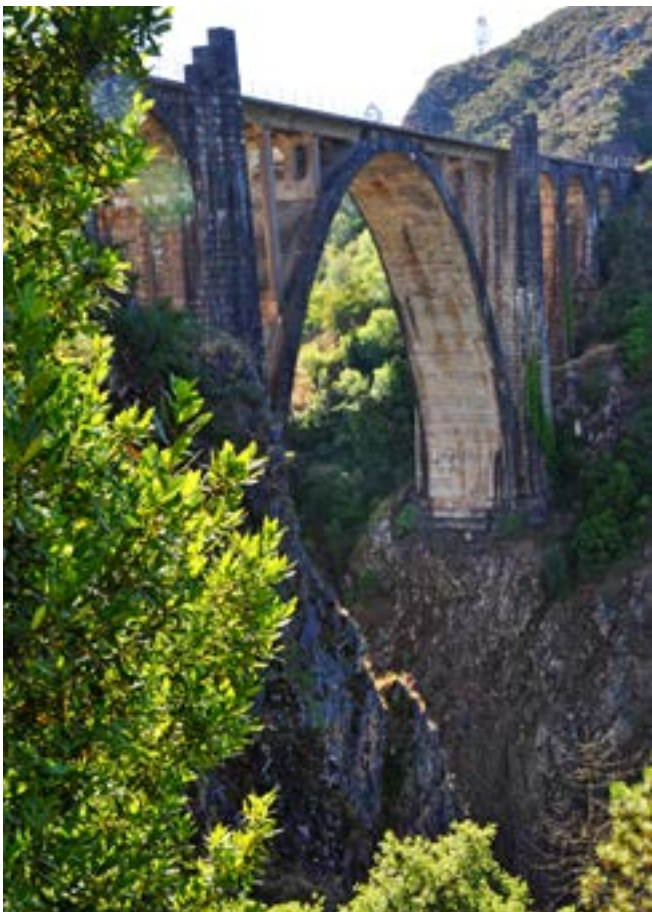
Kamienny, łukowy most kolejowy Gundian w Galicji (obiekt nr 34)
