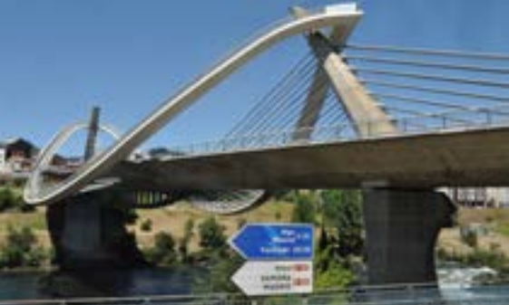
Most Milenijny przez Miño w Ourense (obiekt nr 42), fot. K. Flaga
