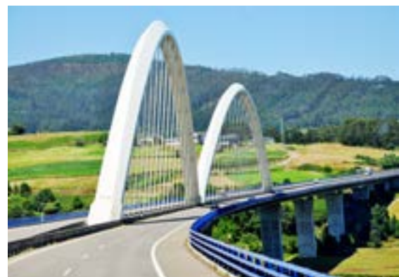
Viaducto del Navia (obiekt nr 31), fot. K. Flaga
