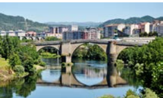
Atrakcja Ourense – kamienny, łukowy most Rzymski (obiekt nr 43), fot. P. Flaga
