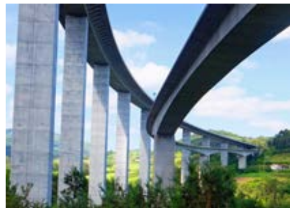
Wiadukty Concha de Artedo (obiekty nr 29 i 30), fot. J. Kędzińska
