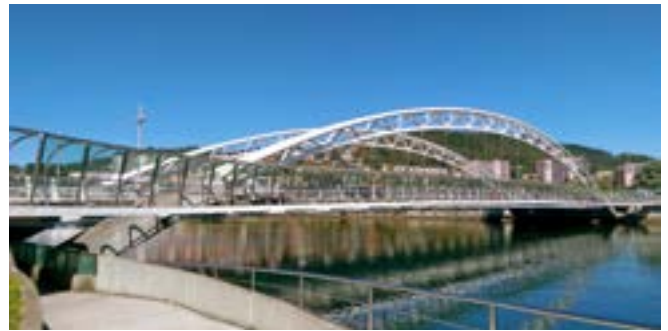
Stalowy most łukowy Corrientes przez rzekę Lérez w Pontevedrze (obiekt nr 36)
