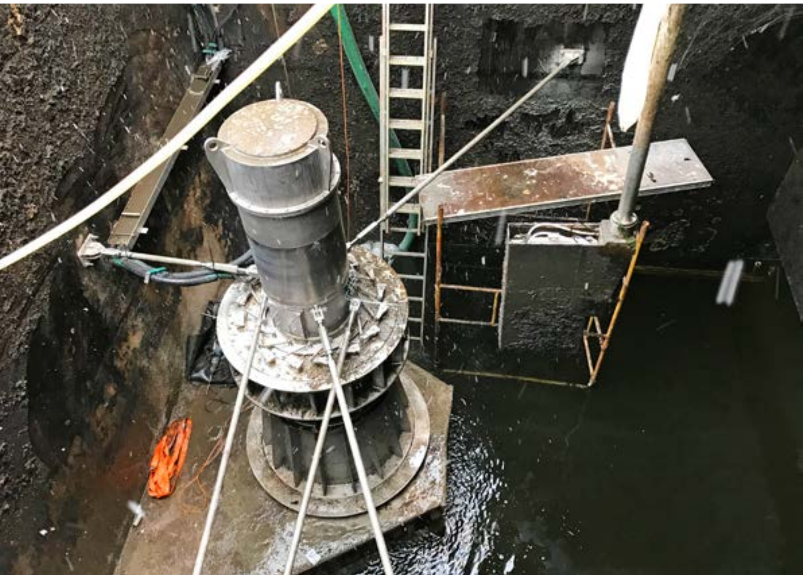
Turbina w trakcie montażu w komorze
