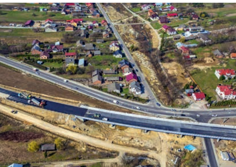
Budowa estakady w miejscowości Nienadówka (obiekt WD14)
