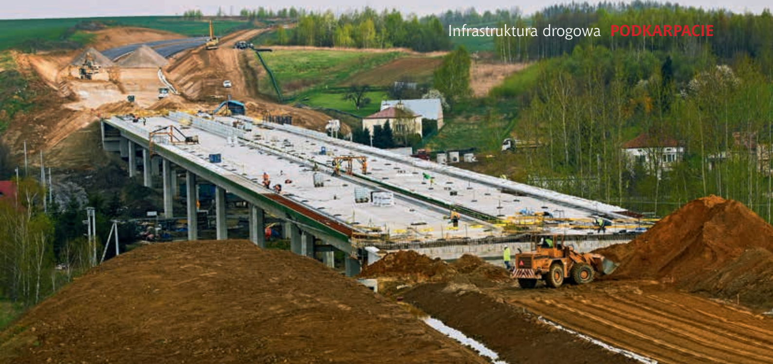
Budowa estakady E1 (Rzeszów, ul. Dębicka)
