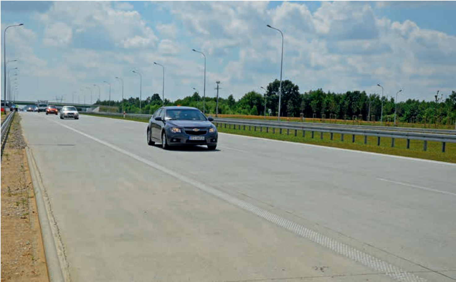
Betonowy odcinek autostrady A1 Stryków – Tuszyn
