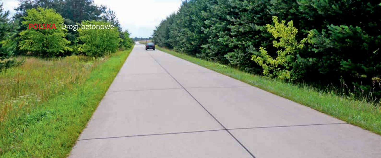
Betonowa droga powiatowa Gliniany – Teofilów w województwie świętokrzyskim po 10 latach użytkowania
