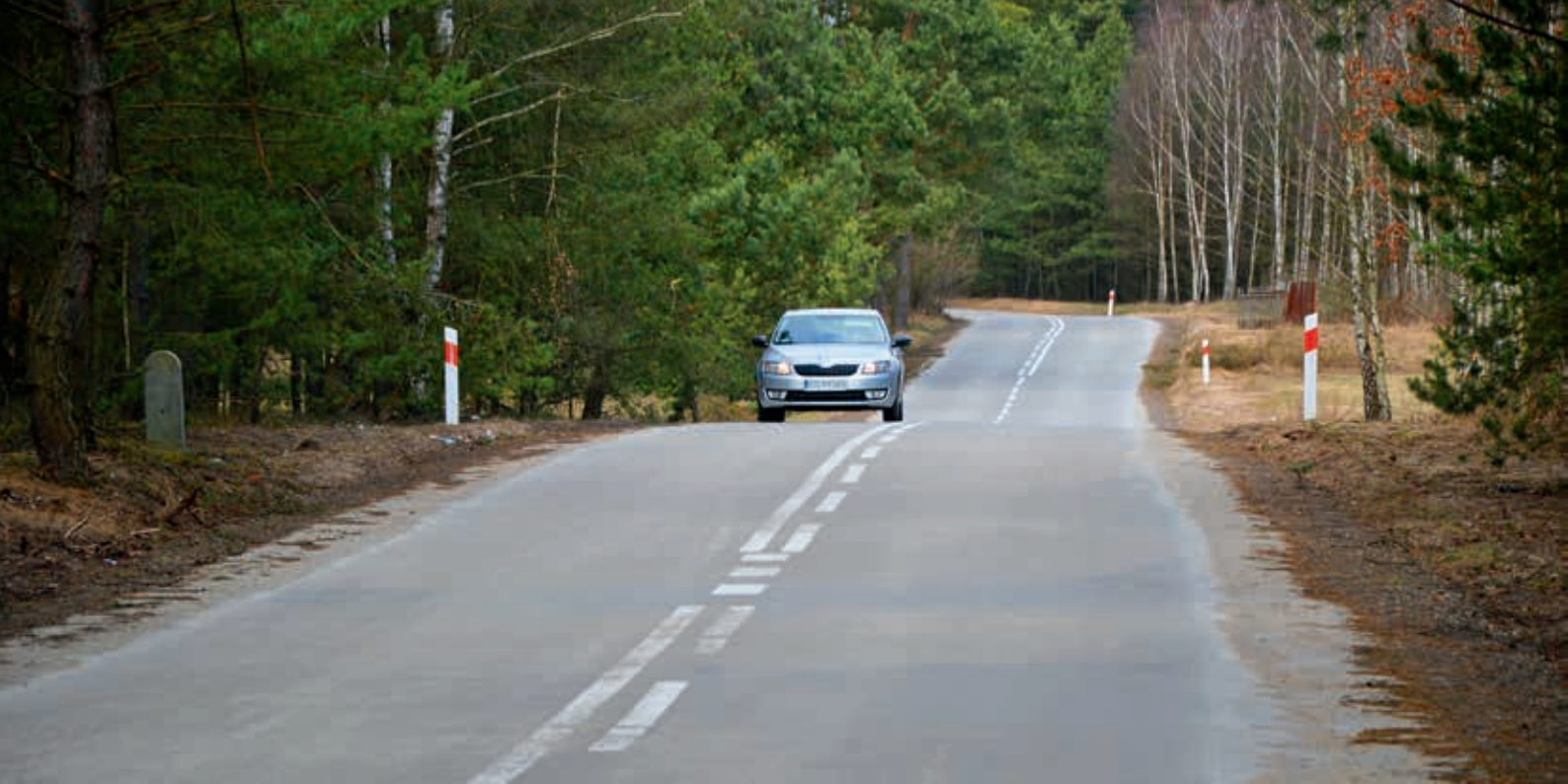
Droga wojewódzka nr 391 z betonu wałowanego, Piła Młyn – Buśnia, województwo kujawsko-pomorskie
