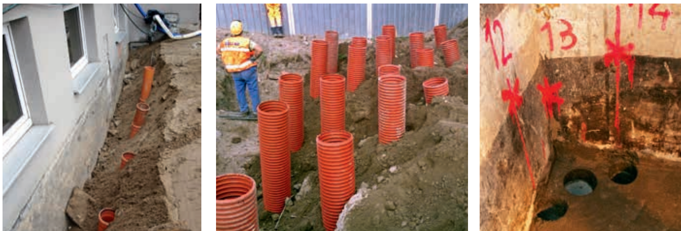
Ryc. 14–16. Prace zabezpieczające instalacje: (po lewej) wzdłuż ściany, (w środku) na placu budowy, (po prawej) przewiertu rdzeniowe fundamentów
