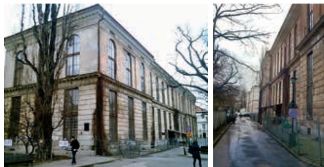
Ryc. 1 i 2. Budynek przed remontem – miejsce na zaplecze budowy (UW)
