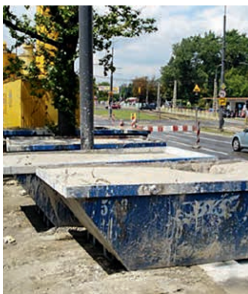
Ryc. 11–13. Metody gromadzenia i usuwania urobku: (po lewej) w betonowozach, (w środku) w kontenerach, (po prawej) w dołach na urobek
