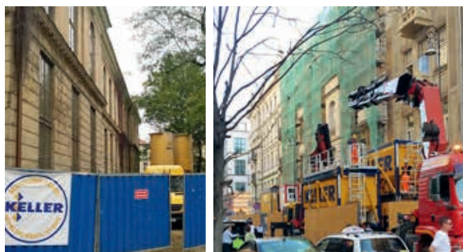
Ryc. 9 i 10. Widok na zaplecze części technologicznej w kampusie oraz w centrum miasta
