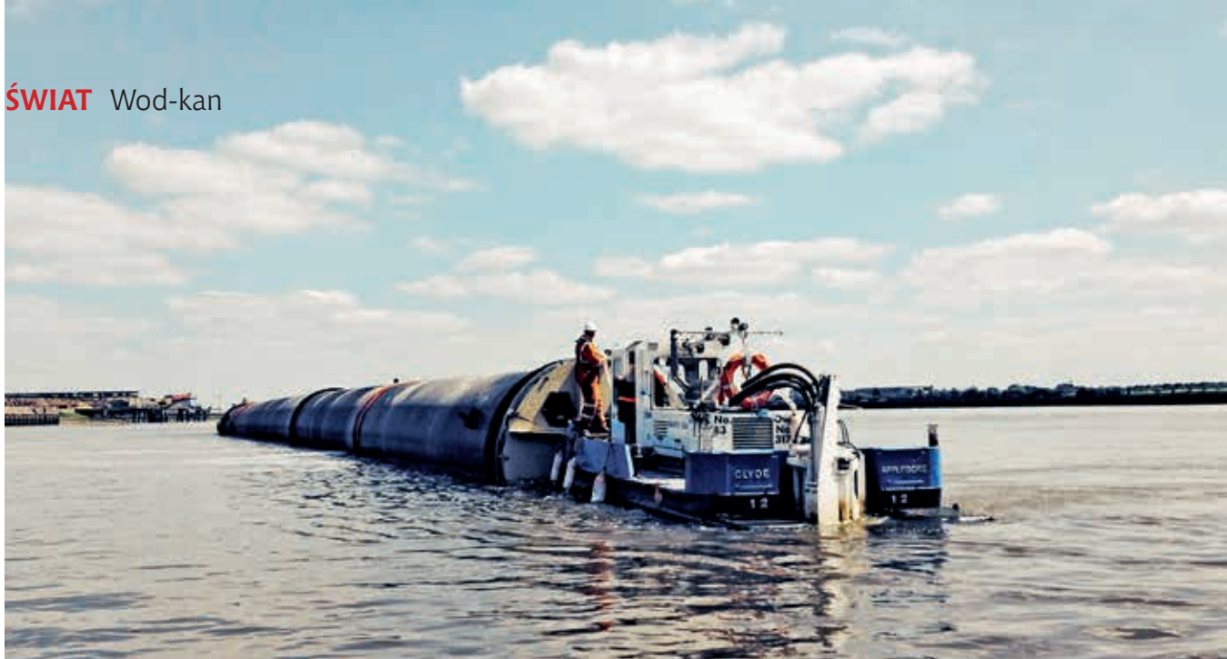
Holowanie sekcji rur PE-HD Weholite w górę rzeki Tamizy
