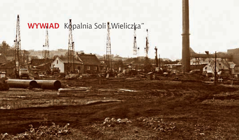
Wiercenie otworów serii R z powierzchni w 1992 r., fot. J. Przybyło
