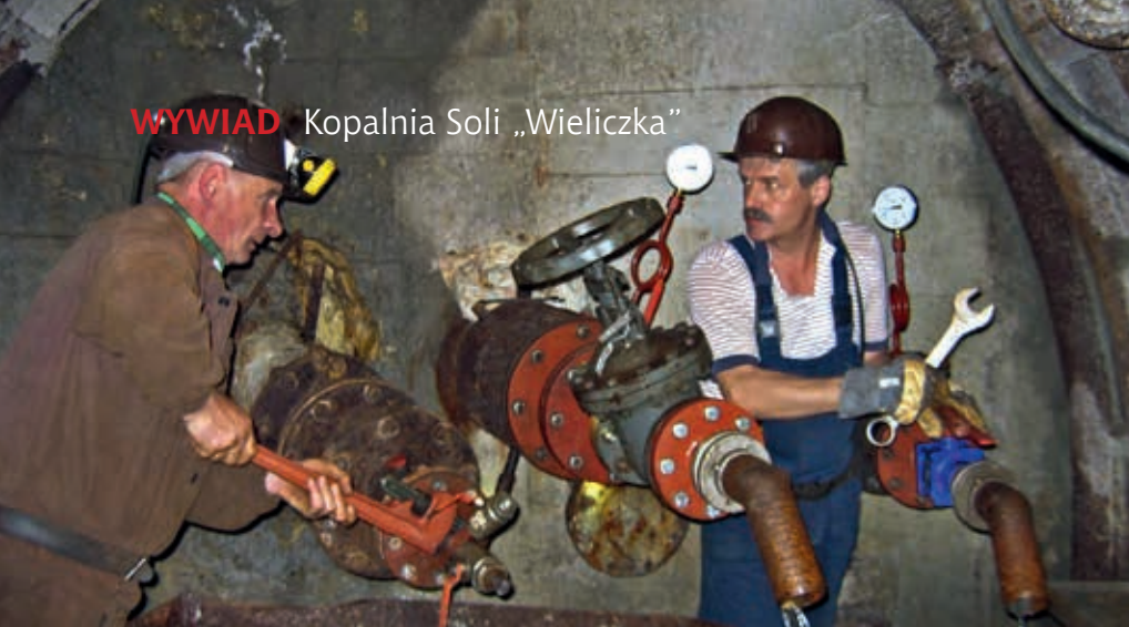
Tama wodna w poprzeczni Mina z otworami drenażowymi D-1, D-2, D-3, 2007, fot. K. Brudnik
