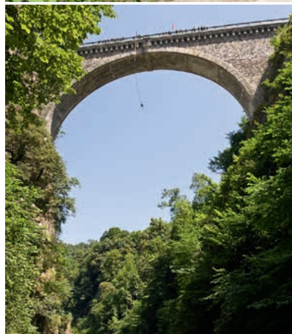
Most Napoleona w miejscowości Luz-Saint-Sauveur (obiekt nr 71)
