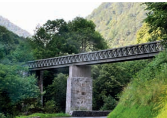
Dwuprzęsłowy wiadukt stalowy nad drogą powrotną do Lourdes
