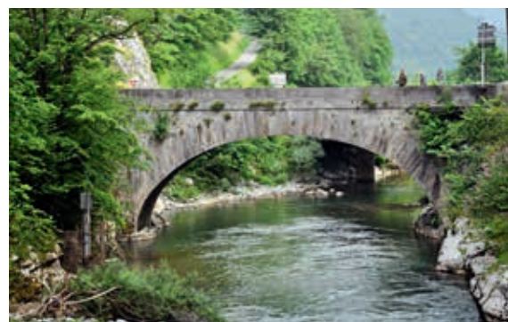
Kamienny most drogowy w Escot (obiekt nr 75)
