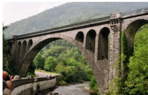
Kamienny most-wiadukt kolejowy w Escot (obiekt nr 74)
