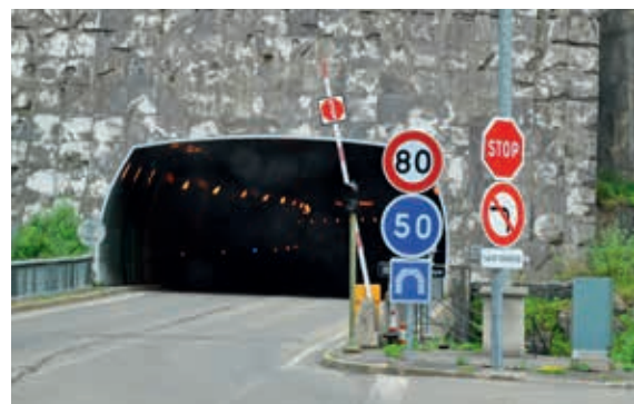
Wlot do tunelu Somport (obiekt nr 76) od strony francuskiej
