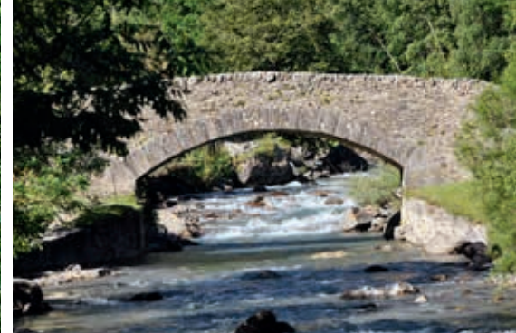
Mostek kamienny Nadáu przez potok Gave de Gavarnie (obiekt nr 69)
