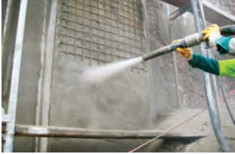
Natrysk torkretu podczas naprawy wiaduktu w Wałbrzychu
