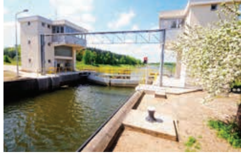
Konstrukcja głowy śluzy w Brzegu Dolnym po naprawie
