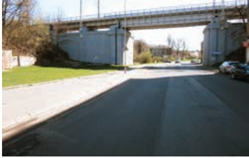
Wiadukt kolejowy w Wałbrzychu po naprawie
