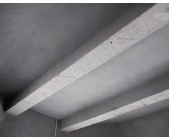
Strop dzwonnicy po wykonaniu torkretu
