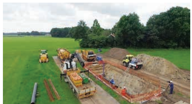
Ryc. 2. Instalacja powłoki w wykopie [1]
