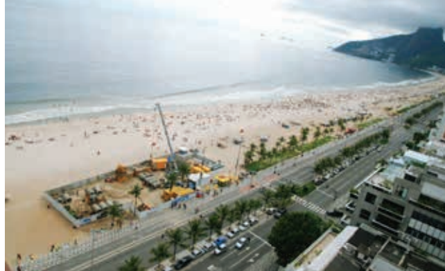
Ryc. 4. Widok z góry na plac budowy [1]
