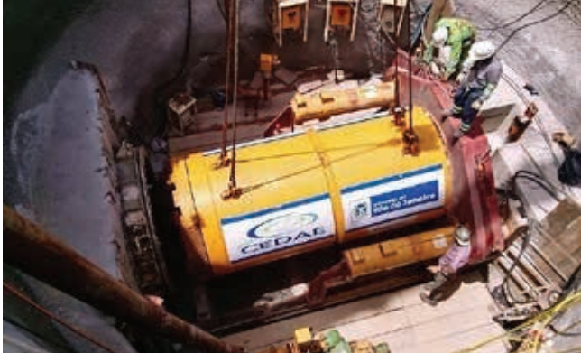
Ryc. 3. Opuszczenie głowicy typu TBM na dno wykopu [1]
