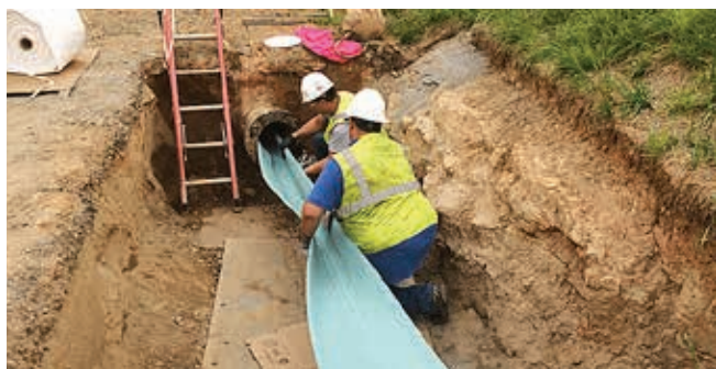
Ryc. 10. Instalacja powłoki Flow-Liner we wnętrzu przewodu [1]
