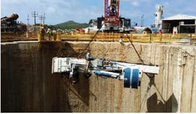
Ryc. 6. Opuszczanie głowicy TBM na dno komory startowej znajdującej się na głębokości 23,5 m p.p.t. [1]
