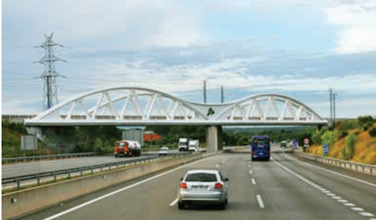
Łukowy wiadukt dwuprzęsłowy z jazdą dołem nad autostradą Girona – Barcelona (obiekt nr 83)
