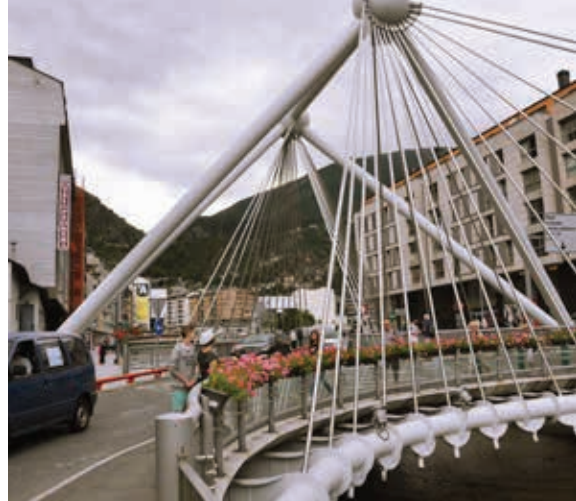
Przestrzennie podwieszony most drogowy w centrum Andora - La Vella (obiekt nr 75)
