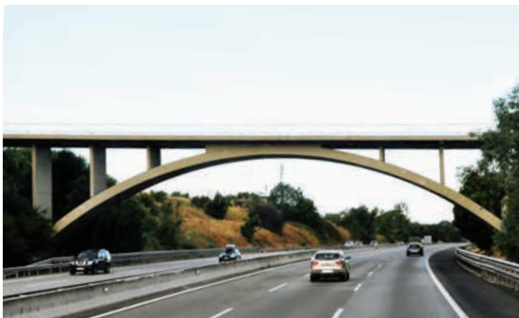
Żelbetowy wiadukt łukowy z jazdą górną nad autostradą Girona – Barcelona (obiekt nr 85)
