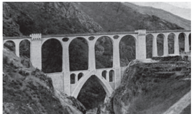
Viaduc Séjourné przez rzekę Tet (obiekt nr 81)
