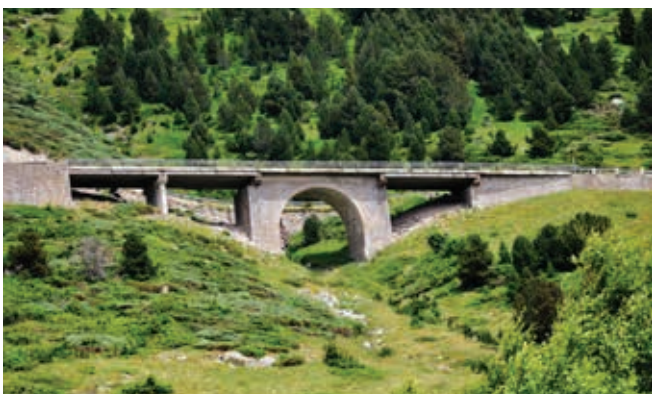
Obiekt mostowy nr 78 na drodze N20 koło Porté – Puymorens
