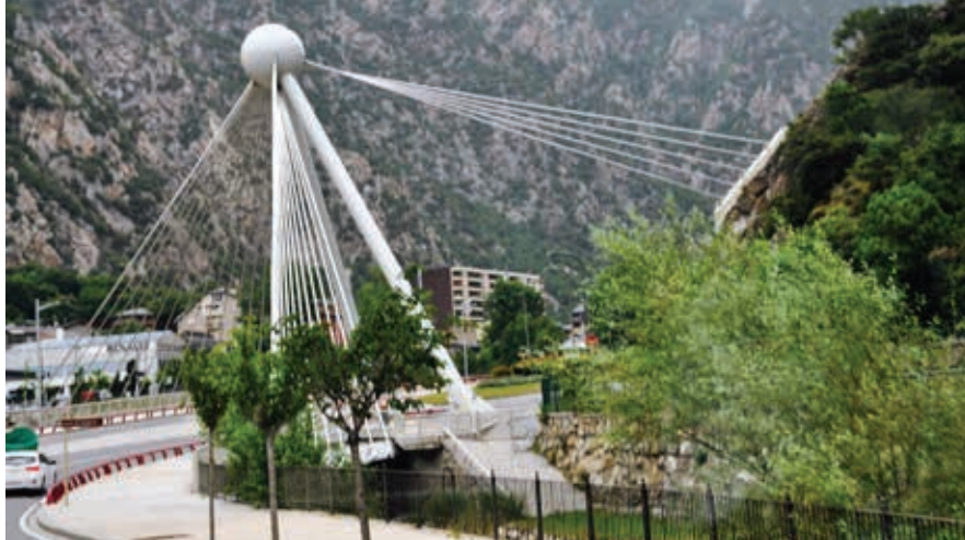
Na wjeździe do Andora La Vella wita przyjezdnych przestrzennie podwieszony most drogowy (obiekt nr 73)
