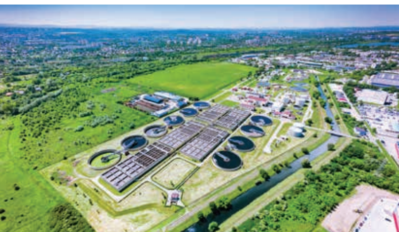
Oczyszczalnia ścieków Płaszów w Krakowie
