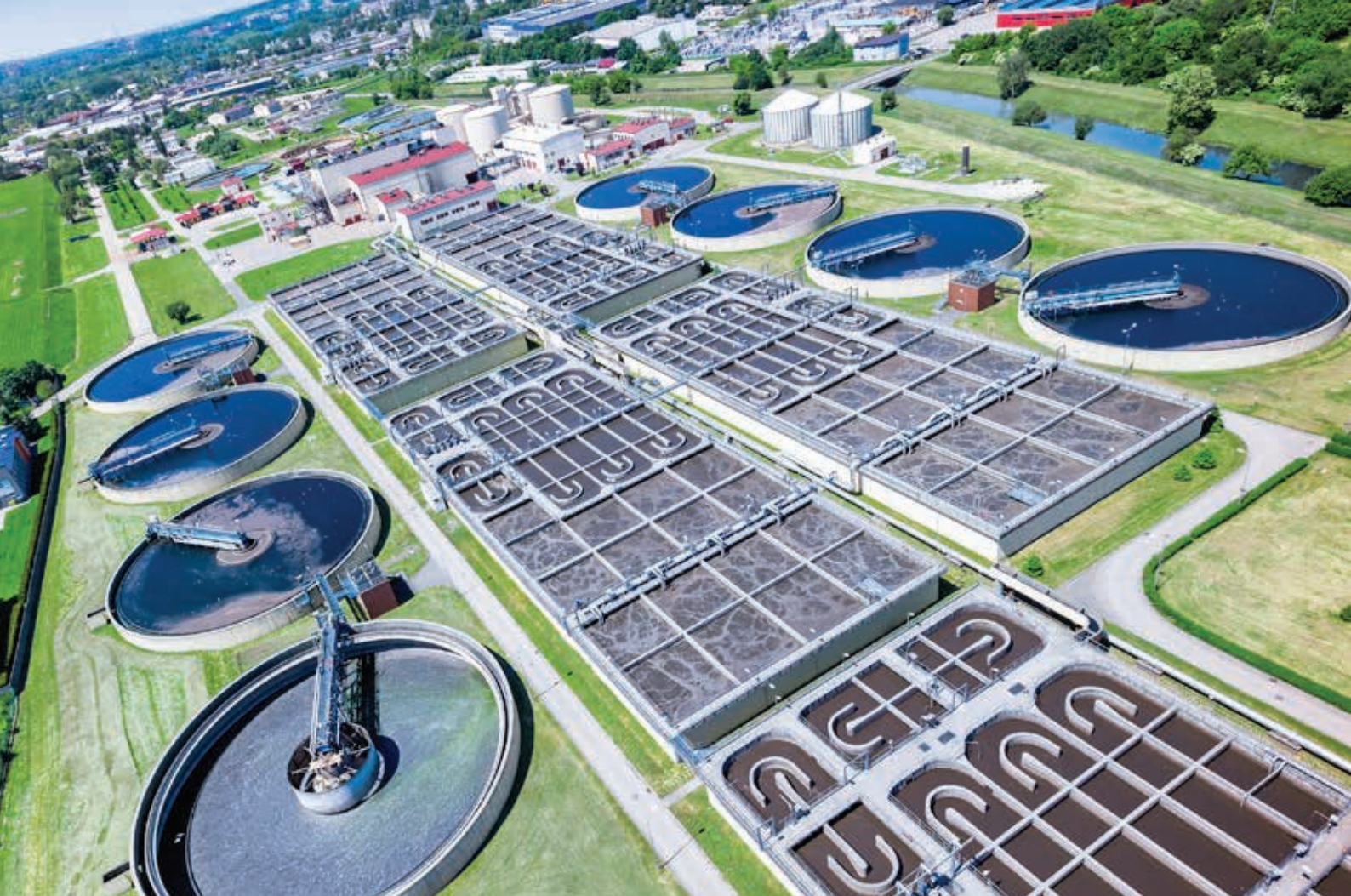
Oczyszczalnia ścieków Płaszów w Krakowie
